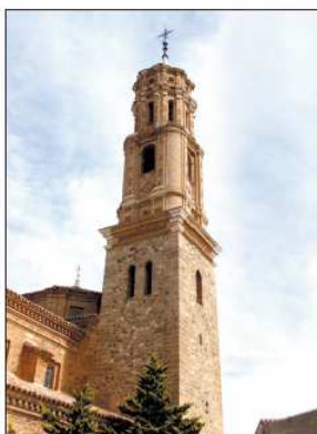
Miguel Bordás construyó la iglesia de Ferreruela y, veinte años después se terminó la torre.
