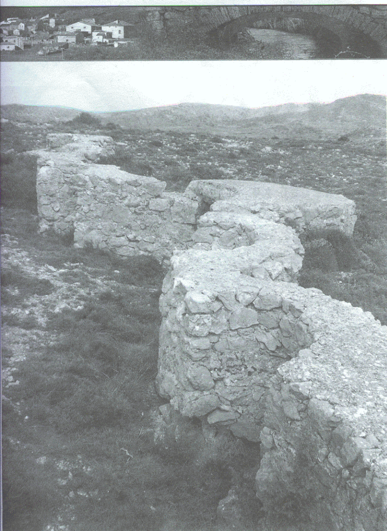
Se conservan en muy buen estado unos 400 metros de parapetos.
